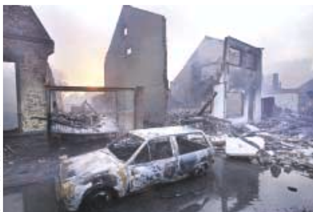
Un aspect des destructions dans une rue proche de l'explosion (Roomweg)
