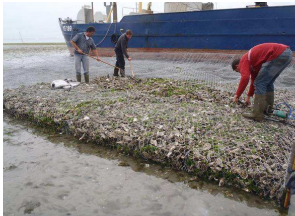
Schanskorven worden gevuld met oesterschelpen en nadien dichtgemaakt.
