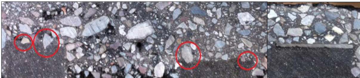
Figuur 2 Aggregaat in gietasfalt
