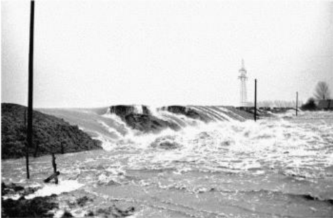
Afbeelding 1. Het falen van een dijk veroorzaakt door golfoverslag (foto: Zitscher, 1976)
