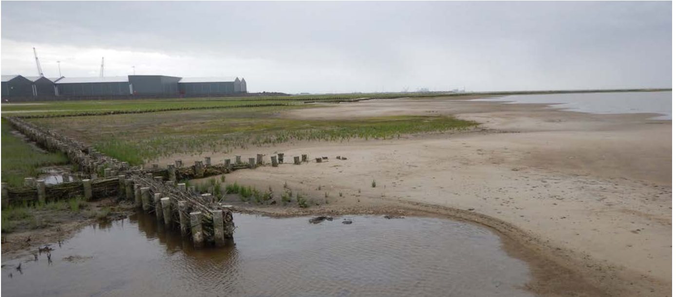
De pas aangelegde kwelderwerken bij de kwelder van Marconi, Delfzijl. Een deel van deze kwelder dient als pilot om kwelderherstel te onderzoeken. (Foto: Pim Willemsen)
