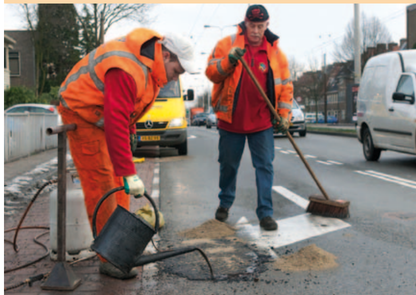
Spoedreparatie aan het wegdek tijdens de vorstperiode afgelopen winter. Foto Luuk van der Lee / HH.
