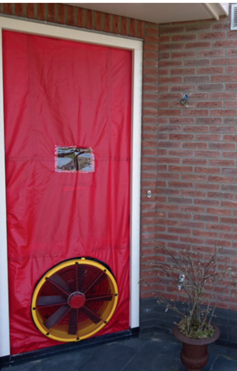
Blowertest op nieuwgebouwde vrijstaande woning.
