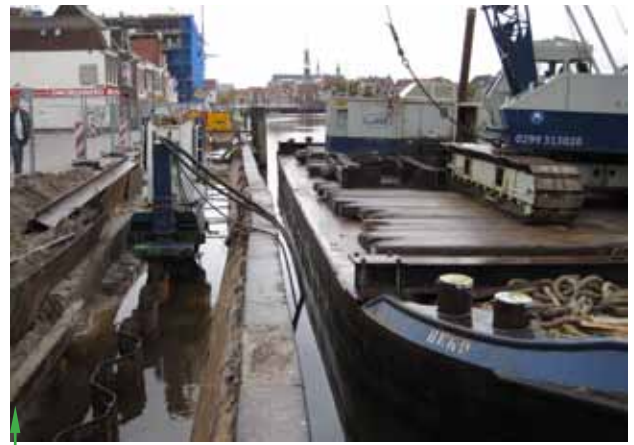
FIG.3 Voormeerkade Alkmaar: Damwandversterking
