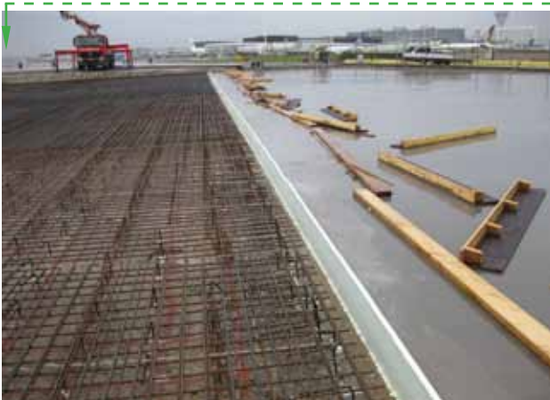
FIG.4 Schipholtunnel: Versterkingsconstructie d.m.v. gewapende druklaag
