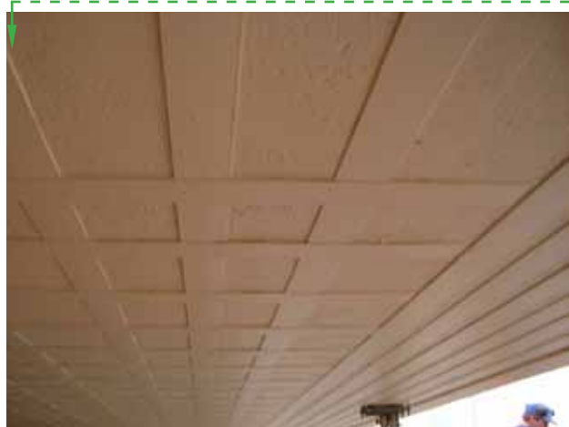
FIG.1 Lijmwapening A28 Zwolle
