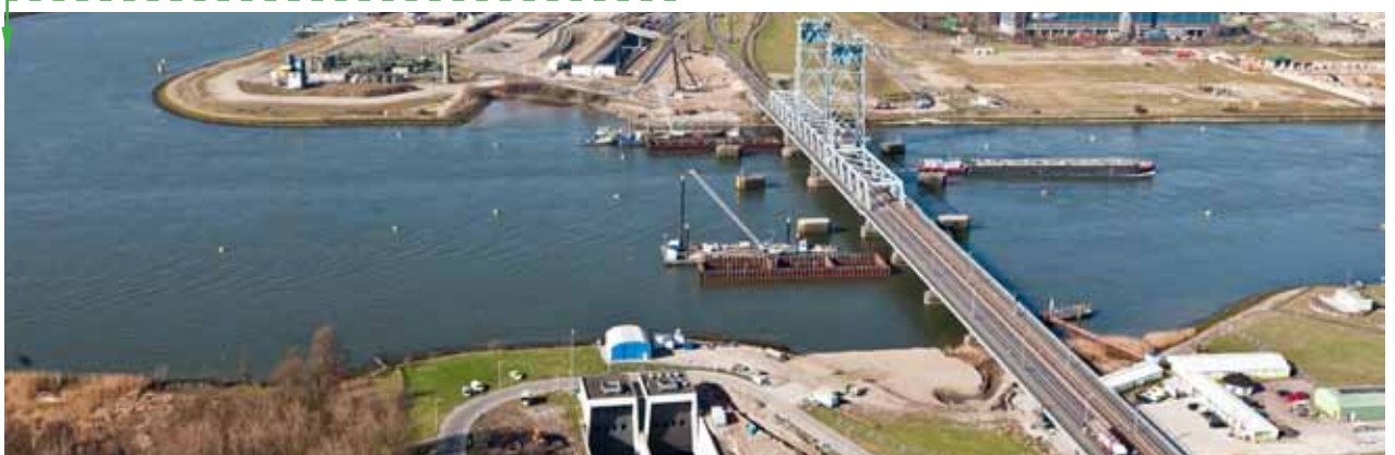
FIG.3 De nieuwe Botlekbrug wordt pal naast de oude brug gebouwd
