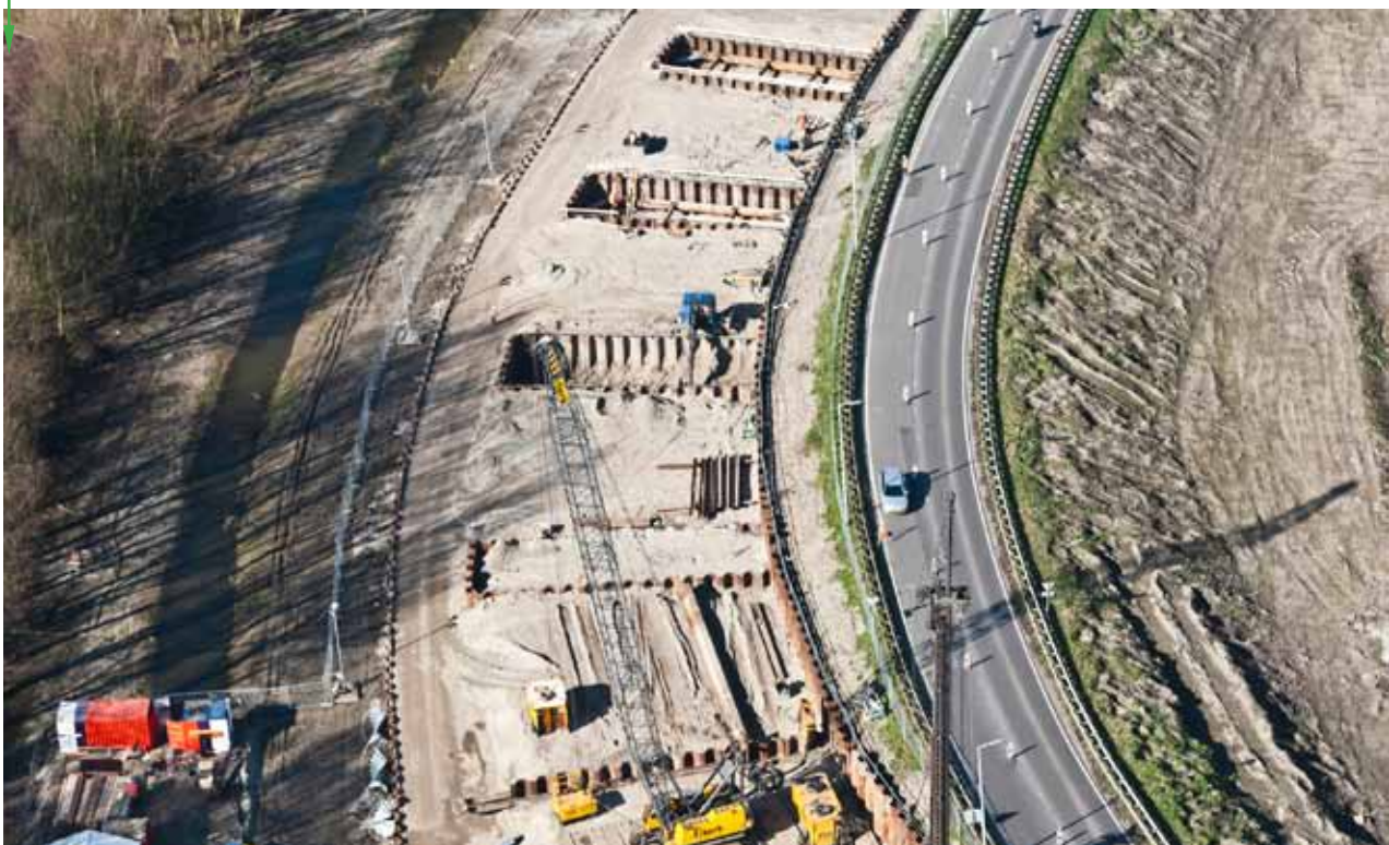
FIG 4. Bouwkuipen van het nieuw te bouwen Oudelandseviaduct bij Hoogvliet
