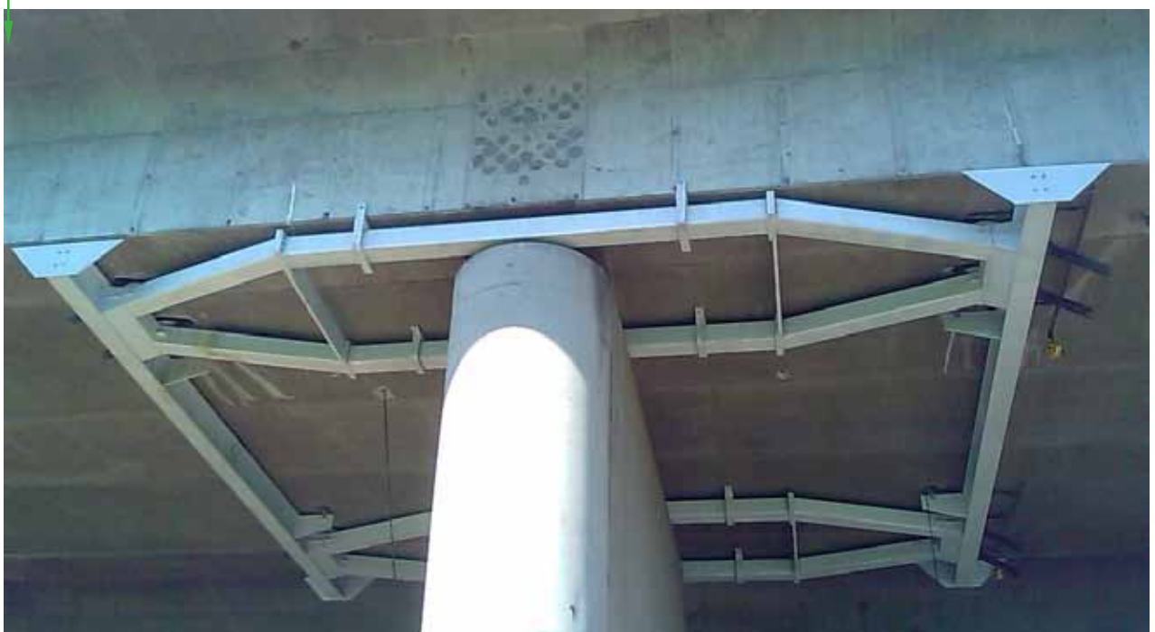
FIG.2 Externe voorspanning kokerligger drukconstructie
